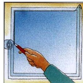
8 - Recouper le film à un format inférieur de 2 mm à celui du vitrage afin qu'il ne touche pas l'encadrement, puis remaroufler.
